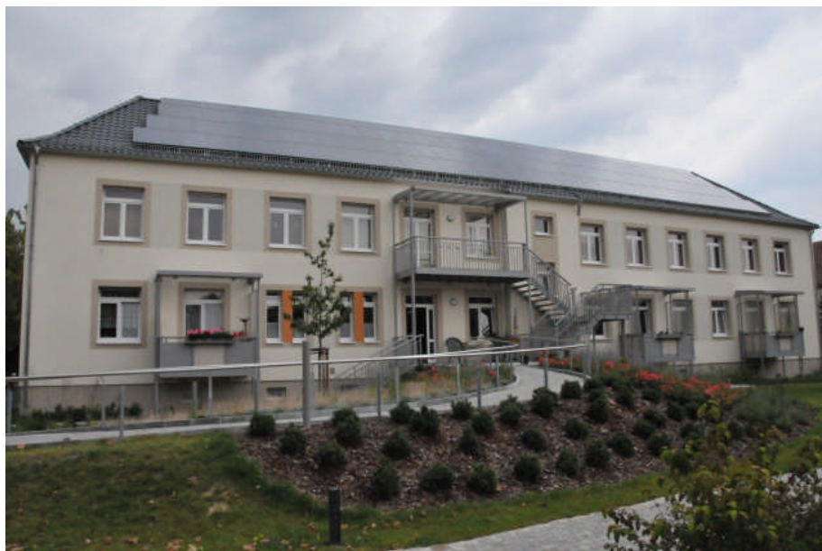
Bild 12: Modul 6 Ansicht Hofbereich mit Photovoltaikanlage, September 2009
